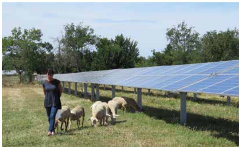
Parc photovoltaïque Arkolia Énergies Le Soler
