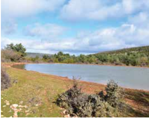
Bassin de collecte d'eau de pluie à Calmels
